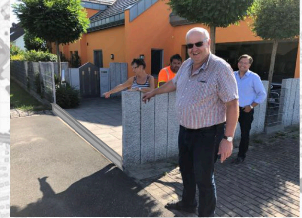
Lagebesprechung mobiler Überflutungsschutz
